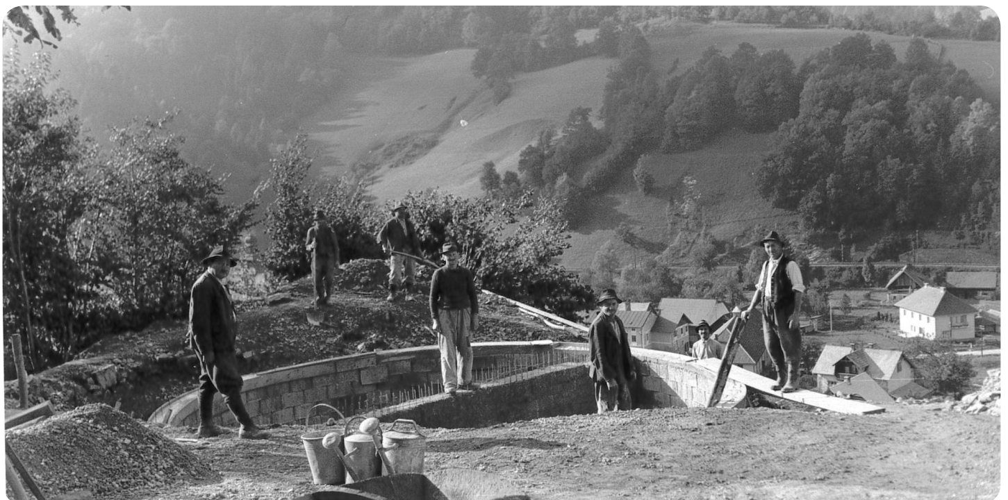
Foto Hochbehälterbau 1956 im Markt, Frankenfels
