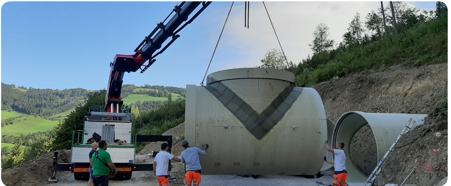
Foto Hochbehälterbau 2021 im Pfarrwald
