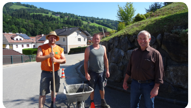
Die Steinmauer oberhalb des Pfarrhofes wurde von Gemeindearbeitern gegen das Abbröckeln und Verrutschen der Steine mit Beton gesichert und somit zur Gänze saniert.
