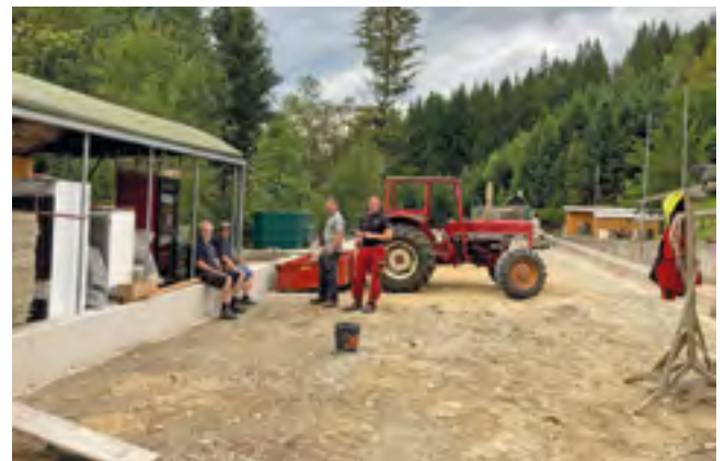
Arbeiten auf der Eisbahn im Pretul
