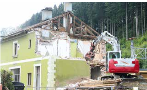
Das alte Bahnhofsgebäude musste weichen
