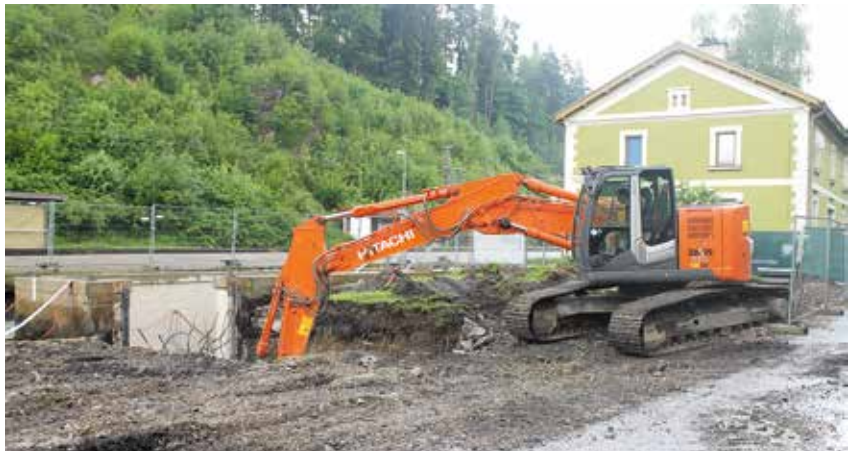
Arbeiten am Bahnhof
