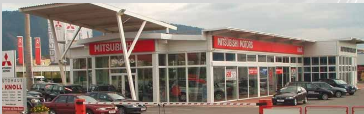
Der vor 20 Jahren neu erbaute Betrieb Autohaus KNOLL in Kapfenberg
