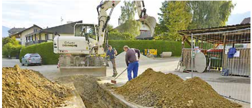
Grabungsarbeiten bei der Hochschloßstraße
