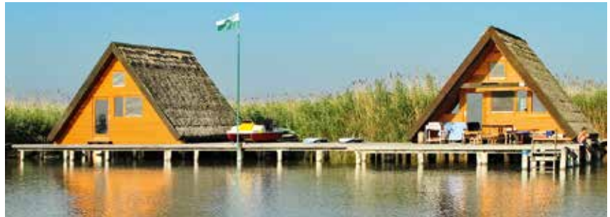
Die Seehütten am Neusiedlersee
