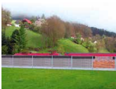
Lärmschutzwände der ÖBB
