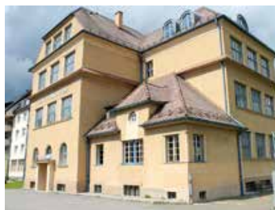
Die „Hauptschule“ wird saniert
