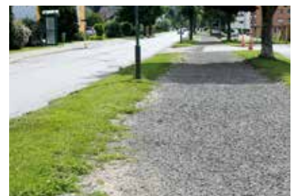
Die Verlegung der Ferngas in den Geh- Radweg wurde fertig gestellt
