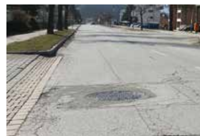
Die L 118 wird saniert
