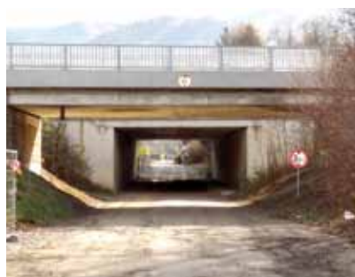
Sanierung der Pretulstraße
