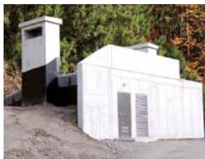
Der neue Hochbehälter
