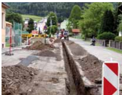
Arbeiten in der Hochschloßstraße
