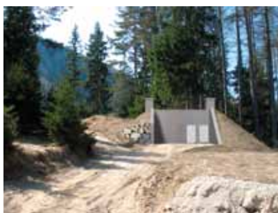
Der geplante Hochbehälter
