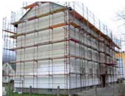
Sanierung Grazer Straße
