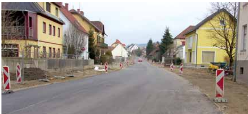
Die Ortsdurchfahrt wird im Frühjahr fertiggestellt.
