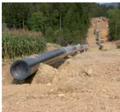
Bau der Erdgasleitung
