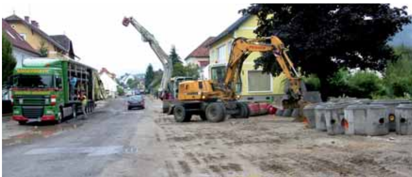
Bauarbeiten bei der neuen Ortsdurchfahrt
