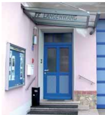
Das neue Eingangsdach
