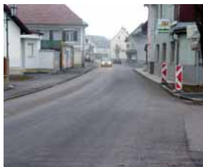
Neu asphaltierter Straßenabschnitt
