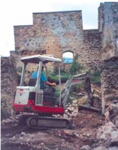
Arbeiten an der Westseite des Palas
