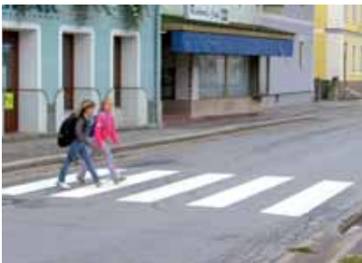
Der neu errichtete Fußgängerübergang
