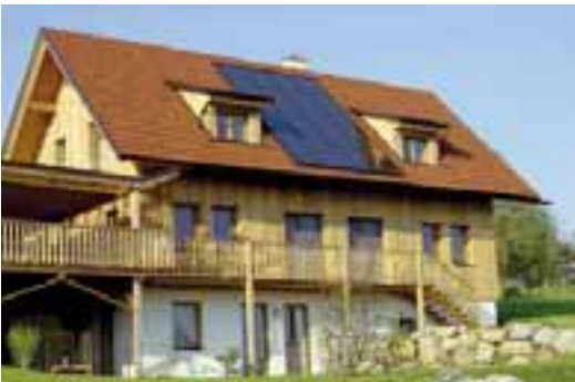
Niedrigenergiehaus mit teilsolarer Raumheizungsunterstützung
