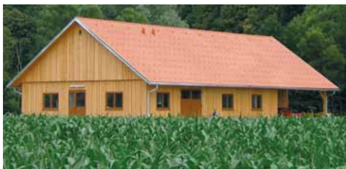
Die neue Abwasserreinigungsanlage in Grasdorf
