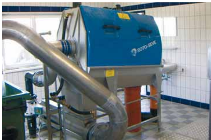
Klärschlamm entwässerungsanlage in der ARA Grasdorf
