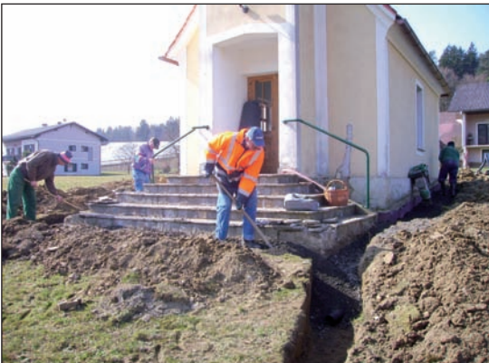
Die Renovierung wurde von Grund auf gemacht
