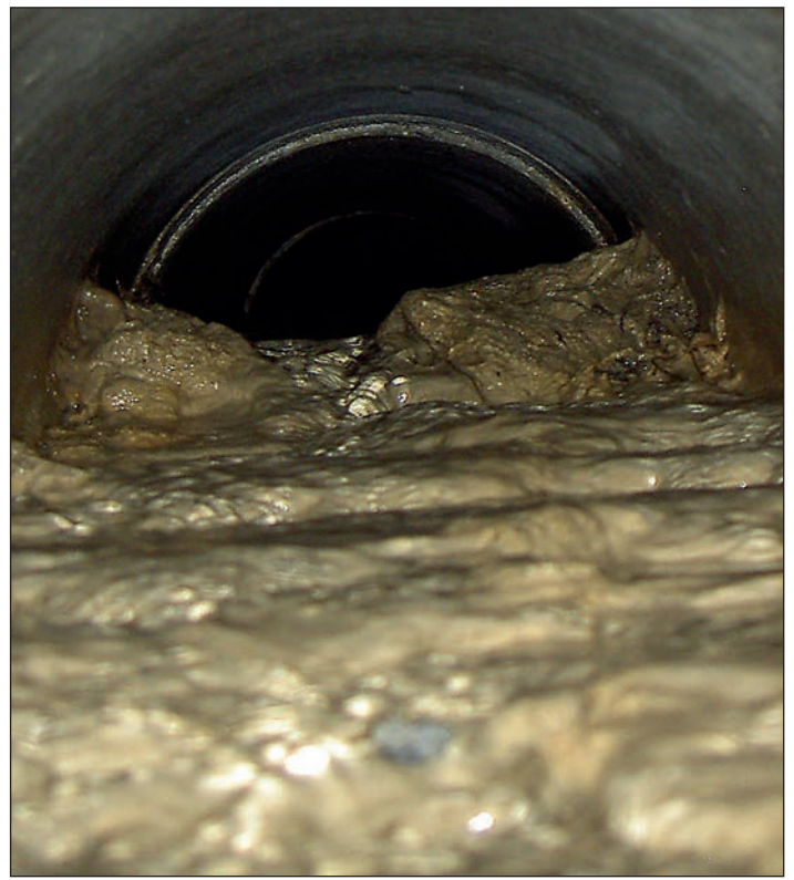
Lugitsch: Fett lässt die Leitungen zuwachsen – auch Ihre Hausanschlussleitung kann betroffen sein!
