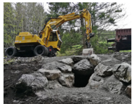
Eine abgebrochene Mauer eines Durchlasses wurde mittels Steinschichtung und Betonfüllung erneuert
