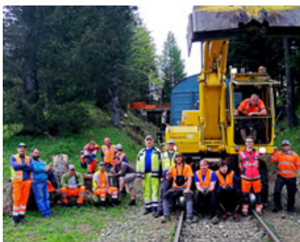
Die Gleisbauwochen wurden mit einem engagierten Personaleinsatz durchgeführt
