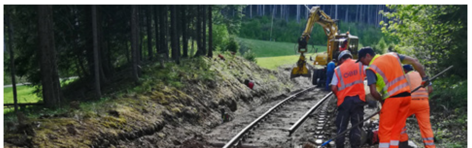
An Gleisbauarbeiten standen an: Gleislagesanierung, Nachschottern und Stopfen, Erneuerung von Schienen und Schwellen, Schweißen von Schienenstößen
