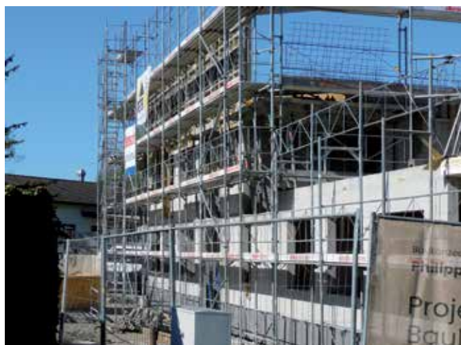
Der Wohnungsbau bei der ehemaligen Bäckerei Kühne geht voran. | Foto: Gemeinde
