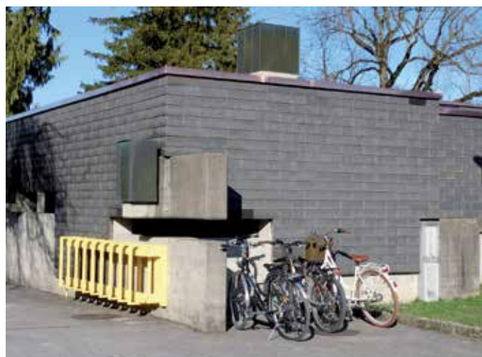
Die Leichenhalle am Friedhof hat ein neues Dach bekommen. | Foto: Gemeinde
