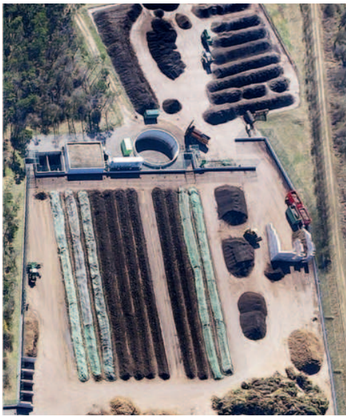
Kompostanlage Breitenau | Foto: © AWV Neunkirchen
