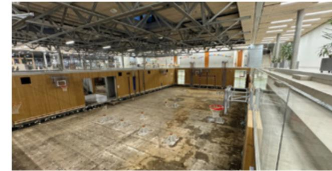
und dem Styropor angestaut, was eine vollständige Trocknung unmöglich machte. Der Boden wurde bis zur Bodenplatte abgebaut, das Wasser abgesaugt und die Fläche gereinigt. Der Fußboden wird in weiterer Folge neu aufgebaut.
