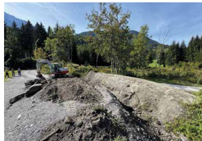
Rohrdurchlass Lambach Mauthen
