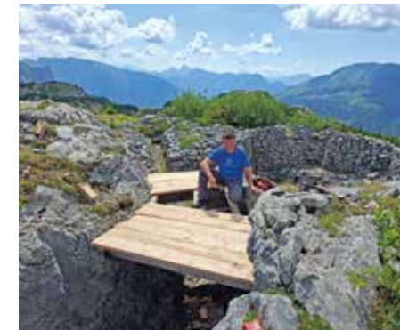
Schützengraben Eindeckung (Mittelkote)
