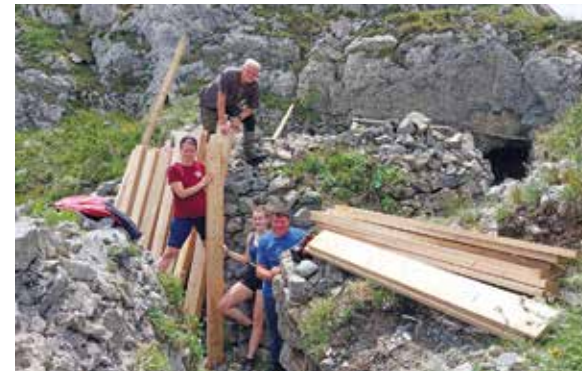
Holztransport zum Objekt im Bereich der Mittelkote
