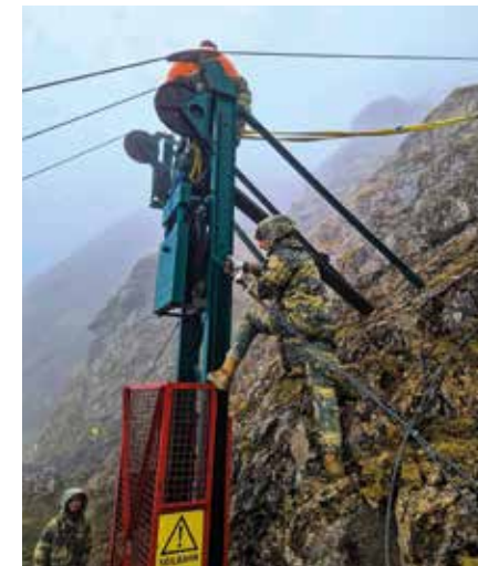
Einhängen des Spanngewichtes für das Zugseil am Kleinen Pal
