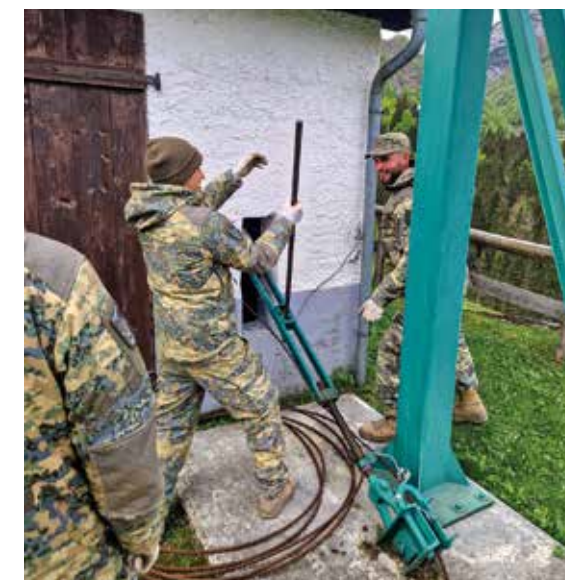
Spannen des Tragseiles der Materialseilbahn
