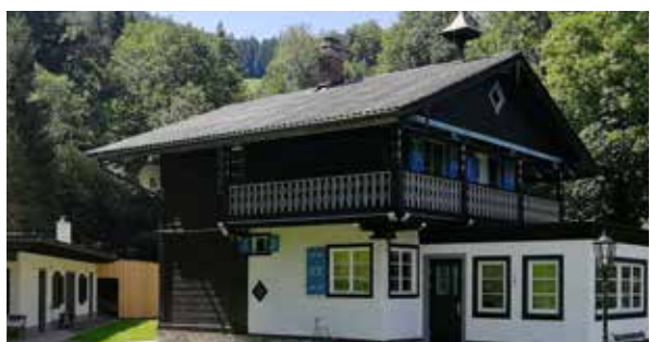
Erdgeschoss erweitert, Nebengebäude neu - das alte Haus bleibt.
