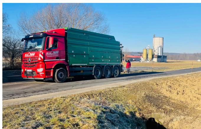
Reinigung eines Straßendurchlasses in der Lahnbachstraße
