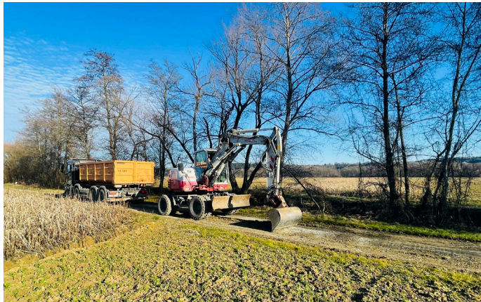
Mehrere Kilometer Feldwege wurden professionell saniert.
