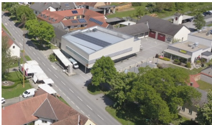
20 kWp PV-Anlage auf dem Dach des Gemeindezentrums
