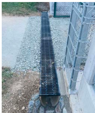
Rigol im Bereich Sportplatz
