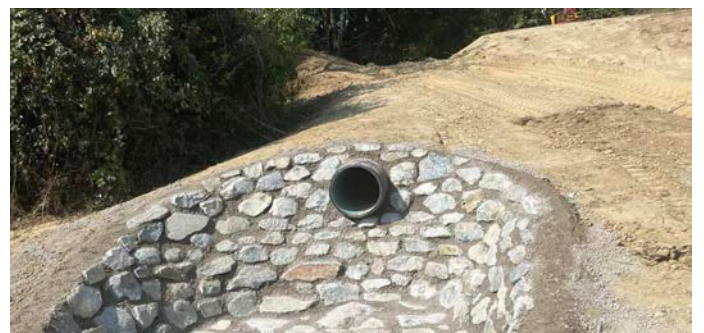
Ableitung "Tiefer Weg" Richtung Rückhaltebecken "Bergstraße"
