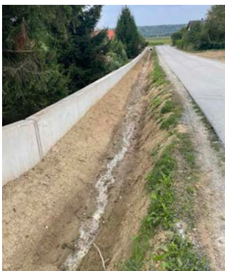
Im Bereich Waldeck wurde eine Schutzmauer errichtet.
