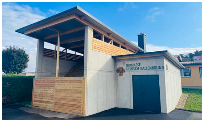
Die Hackschnitzelheizung wurde vor dem Gebäude des Sportvereins errichtet.
