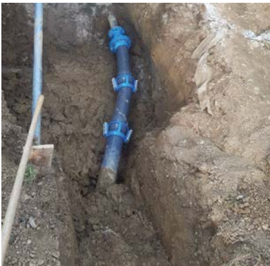
Rohrbruch Hochbehälter
