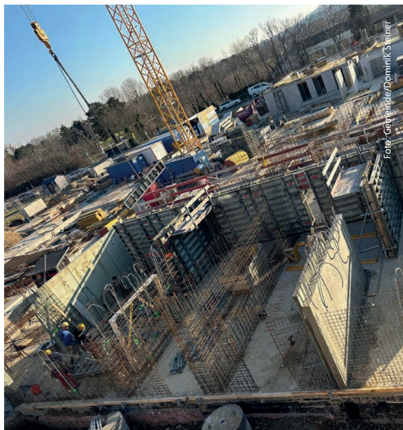
Baustelle des Wohnbauprojektes in der Babenbergerstraße
