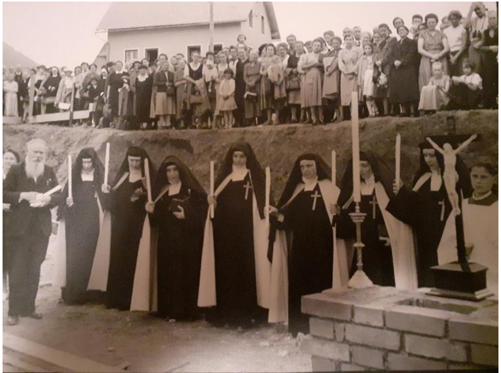
Grundsteinsegnung am 21. August 1955 (Foto: Karmelarchiv)
