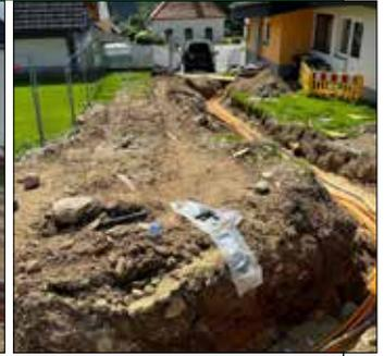
Wie bereits in der Sommerausgabe berichtet, wurden in diesem Jahr weitere Leerverrohrungen für das Glasfasernetz in Rettenegg verlegt. Diese Arbeiten fanden sowohl bei der Erschließung der Baugründe als auch im Bereich der Elinwohnhäuser statt.
