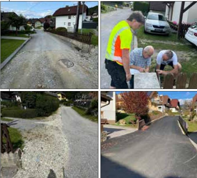
Das größte Projekt des heurigen Sommers war die Siedlungsstraße. Die Arbeiten umfassten das Entfernen der alten, beschädigten Straßenbeläge, die Neuverlegung eines Teilstückes der Gemeindewasserleitung und die Verbesserung der Ableitung der Oberflächenwasserkanäle, um auch bei starkem Regen eine bessere Ableitung des Wassers zu gewährleisten.
