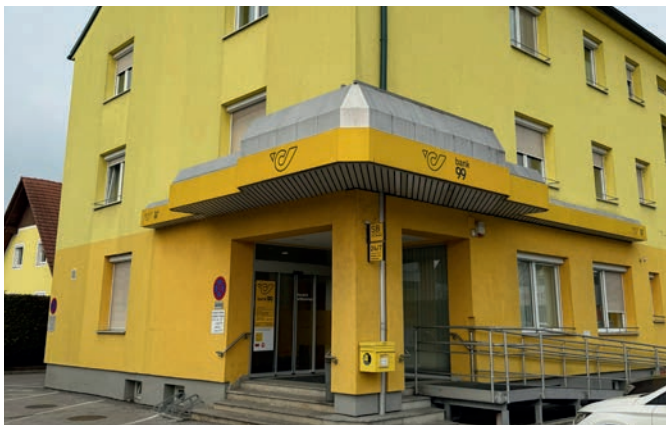
Hier entsteht das Café mit der neuen Postannahmestelle.
