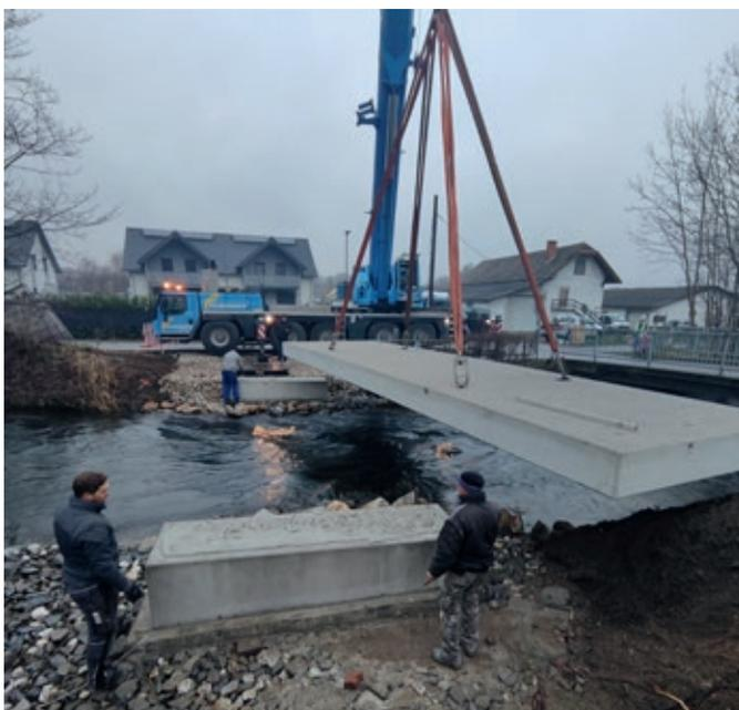
Versetzen des neuen Brückentragwerks über den Mühlgang.
