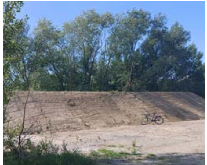
Der neue Damm an der Nordseite der Schlackengrube
