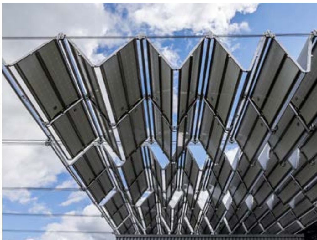
Das Solar-Faltdach wird die Kläranlage in Wildon überspannen
