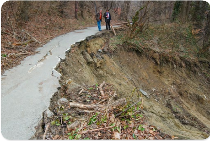
Abbildung 1: Rutschung in der Burggasse im Jahr 2009
