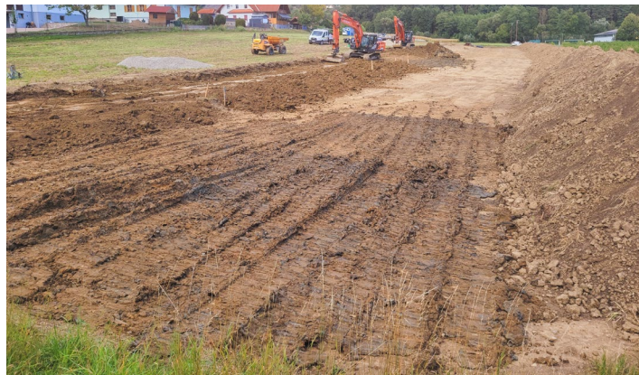
Start der Aufschließungsarbeiten Ortsumfahrung Obertiefenbach
