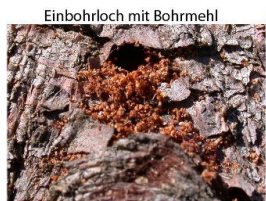
Einbohrloch mit Bohrmehl
