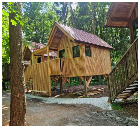
Thomas Mild deckte die Hütten neu ein
