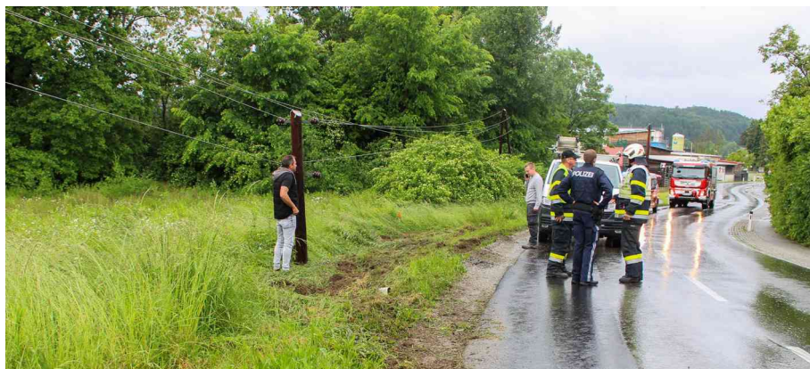
LKW rammt mit Anhänger Strommasten in Kaindorf
