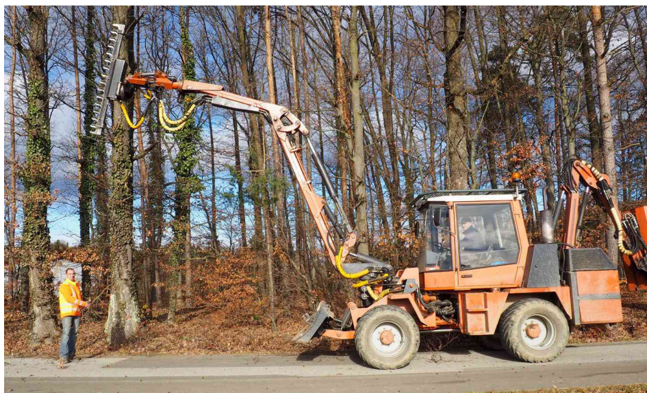
Der Luftraum muss von Ästen und Sträuchern freigehalten werden
