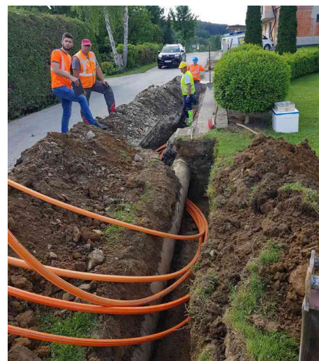
Der Glasfaserausbau war das größte Projekt der letzten 5 Jahre
