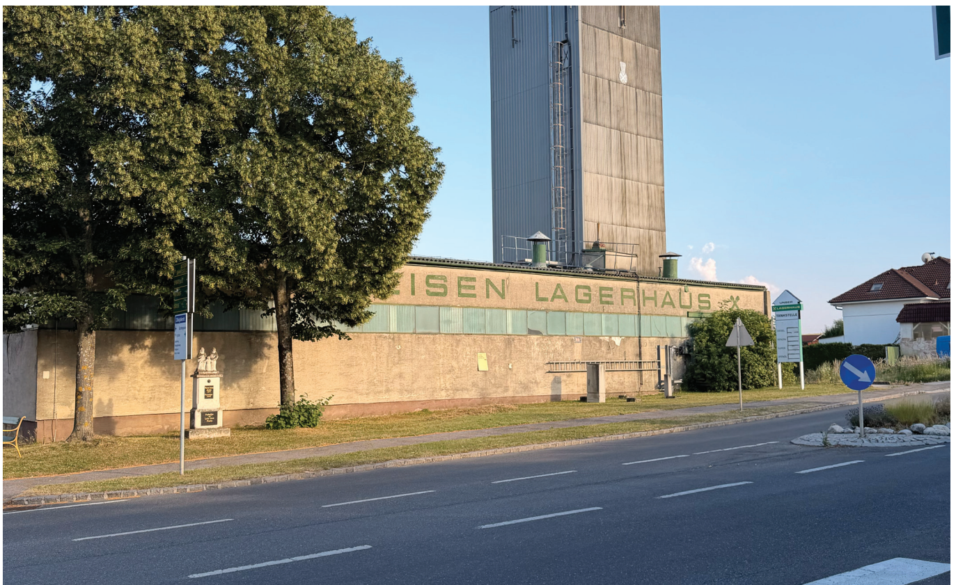
Am Areal des alten Lagerhauses in der Gartengasse sollen künftig Doppelhäuser entstehen.
