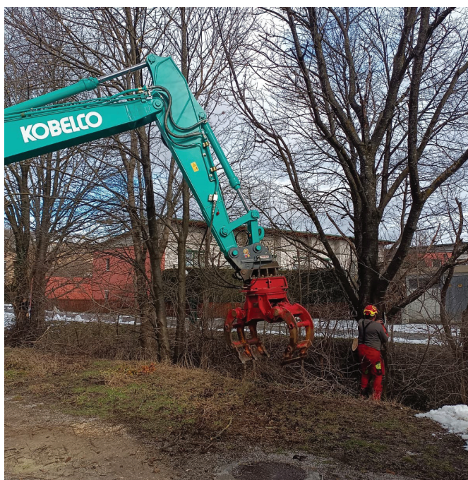
Pflege- und Instandhaltungsarbeiten für einen nachhaltigen Wasserabfluss
