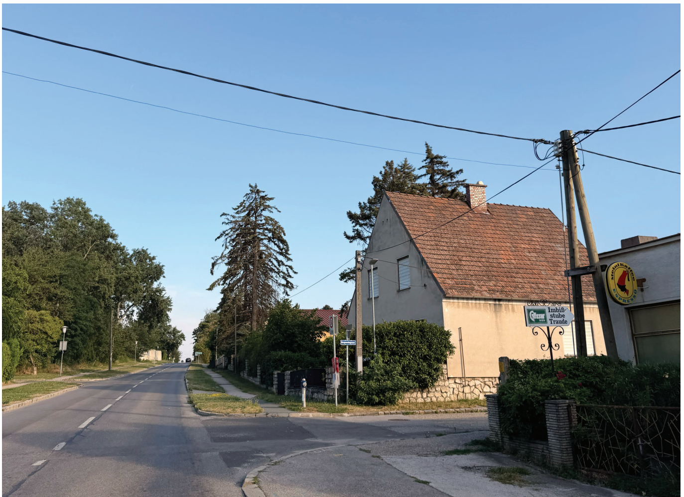
In der Anton-Proksch-Straße entstehen Fahrbahnhaltestellen.
