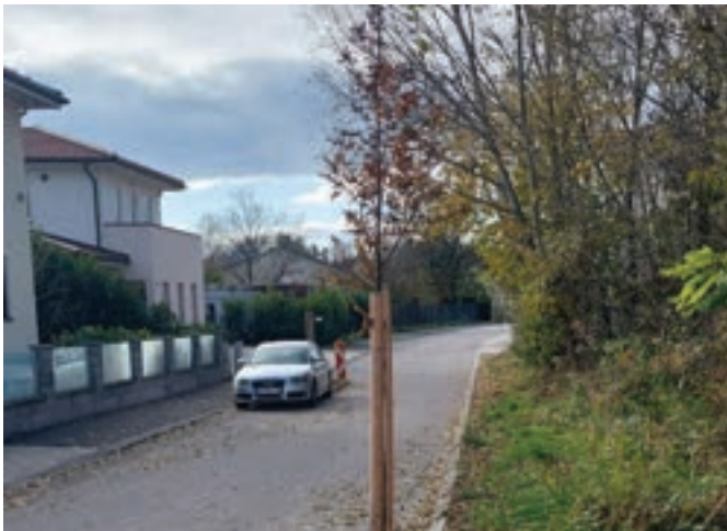
In der Zaunergasse wurde ein Gehweg errichtet.
