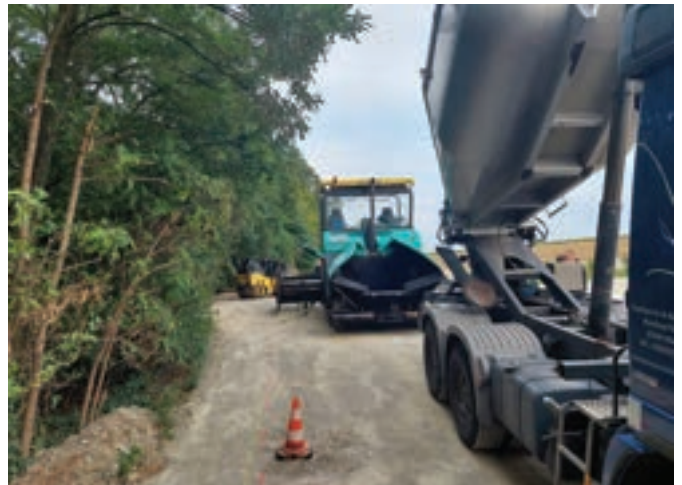
Ein Teil der "Kokica" wurde dieses Jahr asphaltiert.
