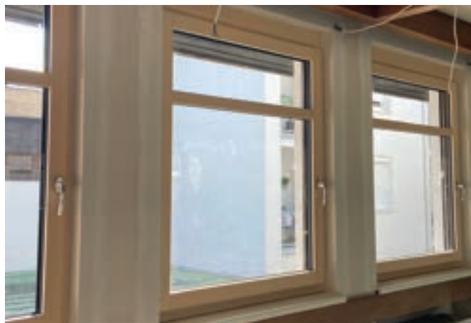
Die neuen Fenster im Sitzungssaal des Rathauses
