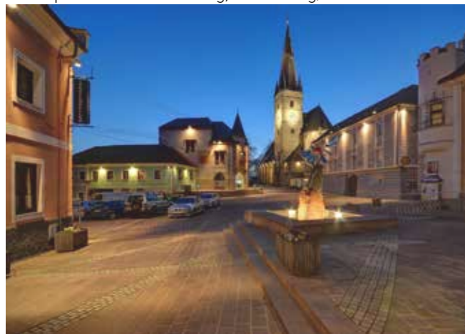
atmosphärische Beleuchtung, Stadt Haag/ NÖ
