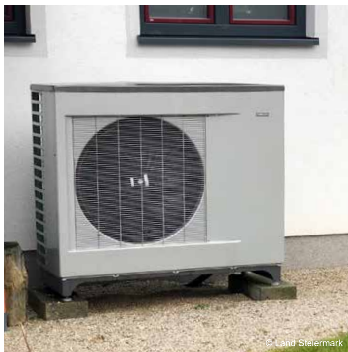
Abbildung: Wärmepumpe im Freibereich
