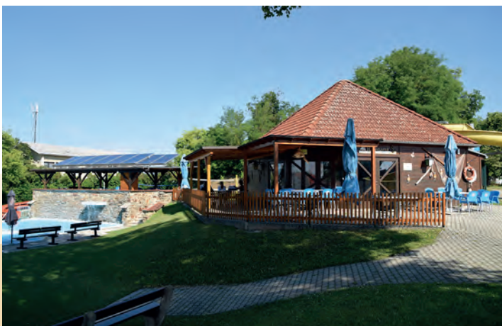
Das Hafenamt von außen
