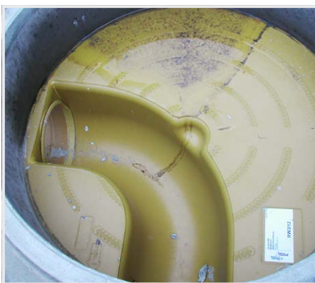
Abbildung 21 | Offenes Gerinne in Schachtboden
