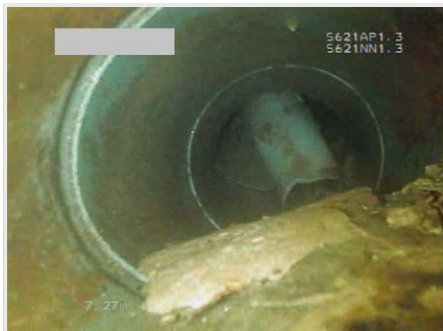
Abbildung 24 | Fehlanschluss (Dachrinne)
