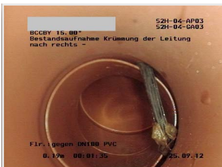
Abbildung 27 | Einragende Dichtung
