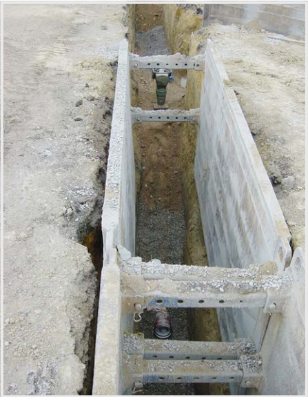
Abbildung 15 | Künette verbaut (Tiefe > 1,25 m)
