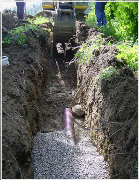
Abbildung 14 | Künette unverbaut (Tiefe < 1,25 m)
