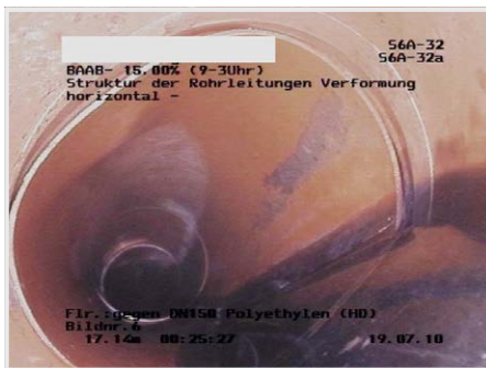
Abbildung 22 | Massive Rohrverformung
