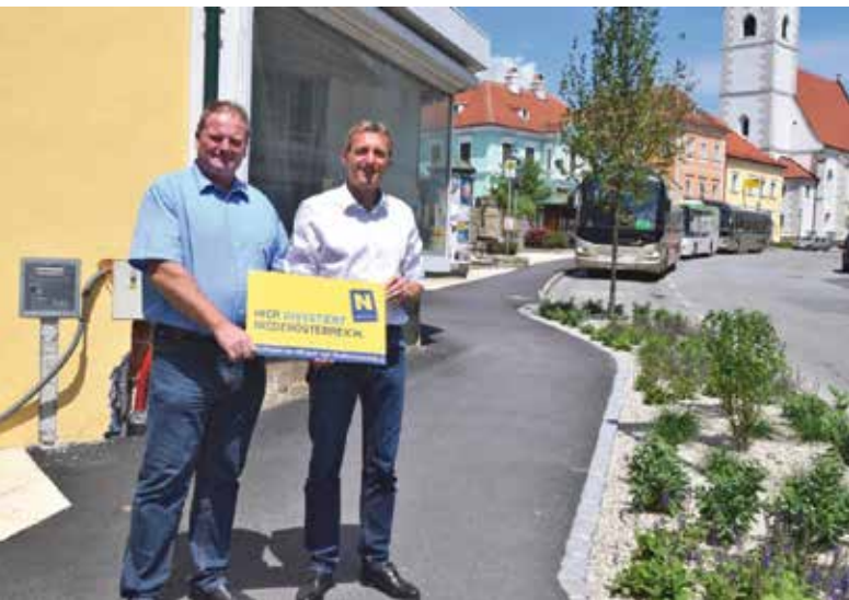
Stiegen wurden entfernt, eine Rampe gebaut und sämtliche Wege neu asphaltiert: Der Hauptplatz kann nun barrierefrei erreicht werden.
