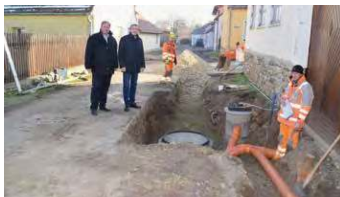
Schon etwas vorangeschrittener waren die Kanalbauarbeiten in Mühlfeld, wovon sich Bgm. LABg. Jürgen Maier und StR Manfred Daniel ebenfalls ein Bild machten.
