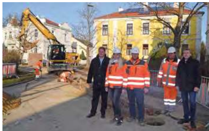
Bgm. LABg. Jürgen Maier und Baustadtrat Manfred Daniel machten sich ein Bild von der Baustelle in der Schulgasse, wo zu diesem Zeitpunkt die Tiefgrabung über 3,5 Meter stattfand.
