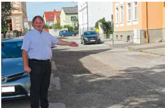
In der Stefan-Weykerstorffer-Straße wurde der Kanal erneuert, die Asphaltdecke wird in den nächsten Wochen abgetragen und anschließend erneuert.
