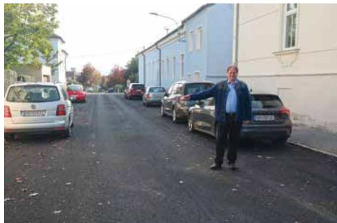
Im unteren Teil der Stefan-Weykerstorffer-Straße wurde die Asphaltdecke bereits aufgetragen.
