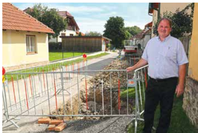
Ein Teilstück des Mühlfelder Regenwasserkanals musste erneuert werden. In Zuge dieser Arbeiten wurden gleich größere Rohre verlegt, um weitere Hochwasserschäden zu vermeiden.
