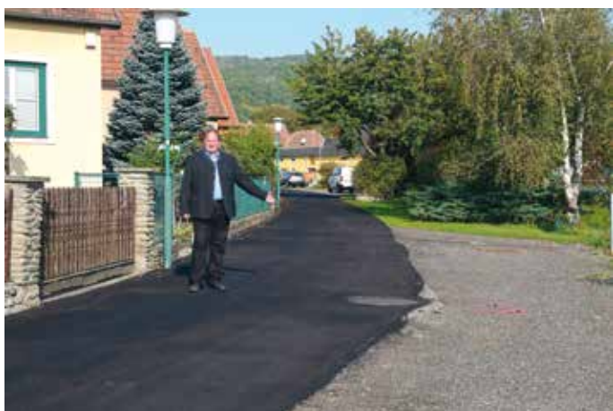
In der Mödringer Bachstraße wurde eine Spritzasphaltdecke aufgetragen, die Nebenflächen wurden mit KRC-Material befestigt.
